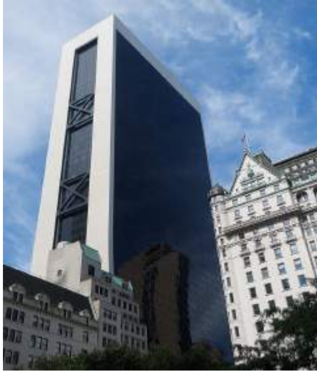
مبنى سولو في وسط مانهاتن، مدينة نيويورك
