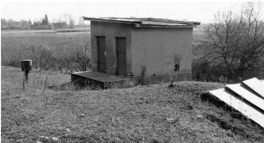
الشكل ٩-٢٣ غرفة الصيانة والخزان المغطى بالعشب مع فتحة تهوية واحدة ومدخل بغطاء معدني، أوبيكفيت نبع بالقرب من صوفيا، بلغاريا.
