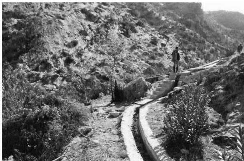
الشكل ٩-٦ قناة خرسانية نموذجية لتحويل مياه الينابيع من الجبال نحو السهل (بوتاس، زاخو، شمال العراق).
