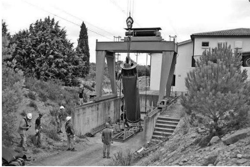
الشكل ٥-٢٦ استبدال المضخات في نبع ليز. (الصورة من جان ميشيل فالي).
