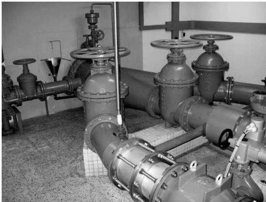
الشكل ٩-٢٥ الأنابيب والصمامات ذات القطر الكبير المستخدمة لتحويل المياه في اتجاهات مختلفة.
