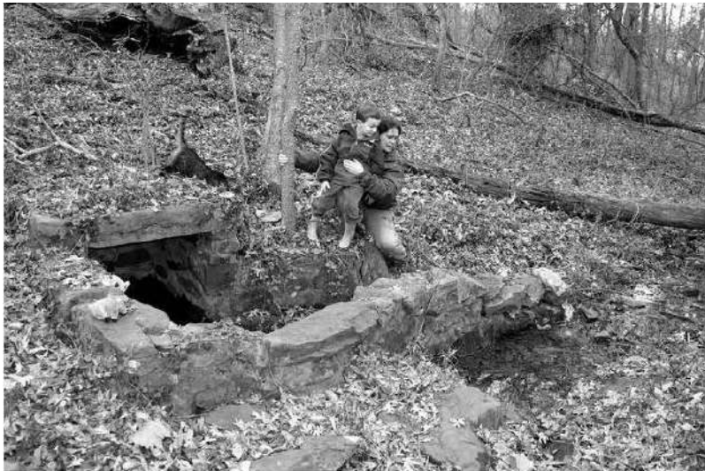
الشكل ٢-٨ التقاط بسيط لمياه نبع صغير يتدفق من الشقوق الصخرية، وقد تم بناء حوض التقاط مياه النبع منذ القدم. (Neven Kresic, 2008).
