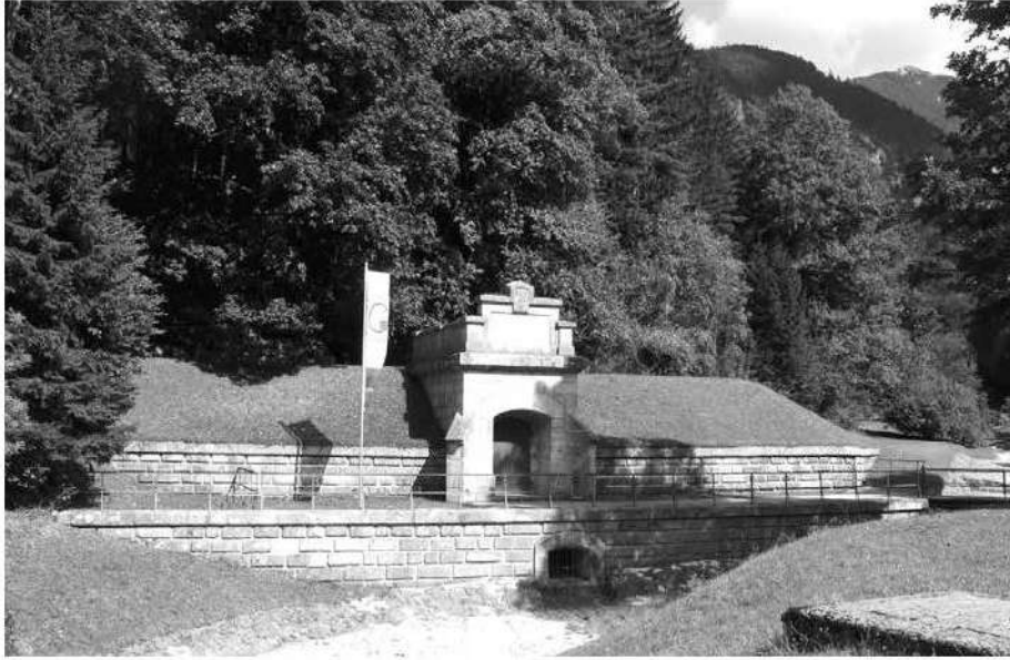
الشكل ٩-٢٢ نبع كايزربرون المستخدم لإمداد فيينا بالمياه منذ القرن التاسع عشر. يظهر المأخذ المغطى بالعشب والخزان مع مصرف فيض بقطر كبير أسفل المدخل الرئيسي.
