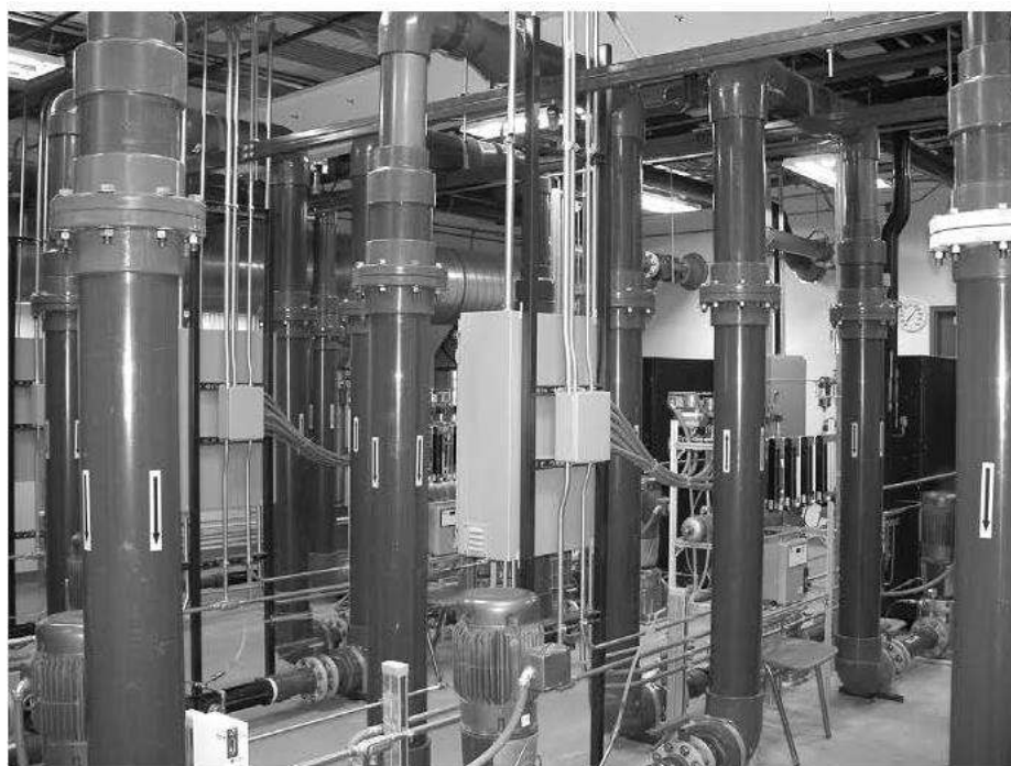
الشكل ٧-١٢ نظام المعالجة بالأكسدة والأوزون المتقدم على نطاق كامل لمعدل تدفق ١٣٠٠ جالون في الدقيقة. التصميم وهندسة فرساد فتوحى، شركة بال.
