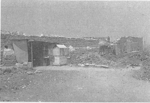
شكل ٢٨: بقايا الخانقاة النظامية - أثر رقم ١٤٠ (٧٥٧هـ / ١٣٥٦م) جزء من سور القاهرة القديم ومعه بقايا الخانقاة
