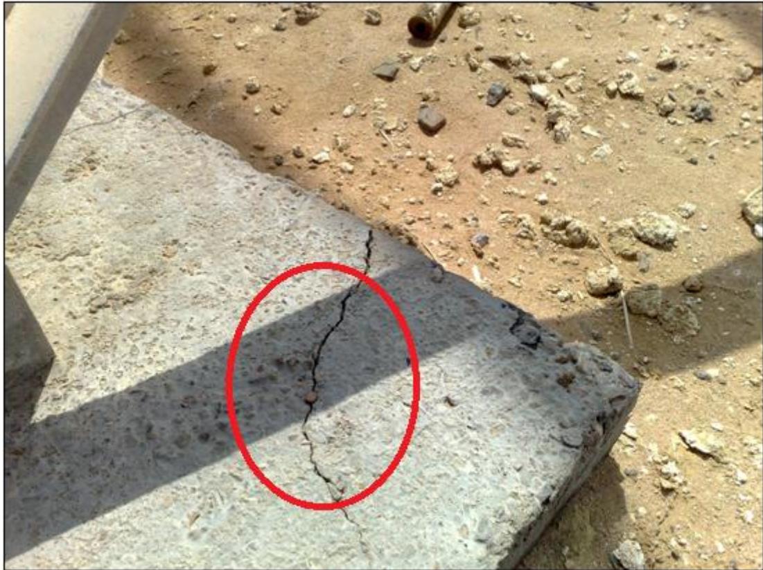
الشكل رقم (٢٥) : تشققات بالقاعدة الخرسانية
