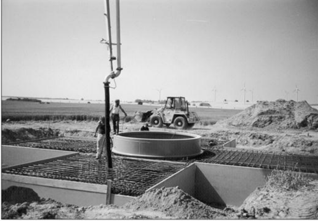
الشكل رقم (٥٢) : تنفيذ القاعدة الخرسانية
