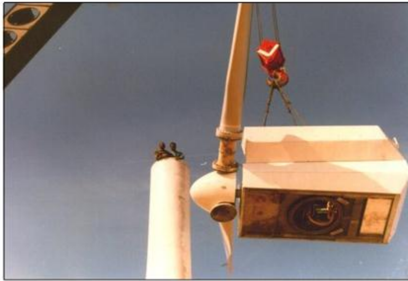
الشكل رقم (٨) : رفع الناسيل فوق البرج
