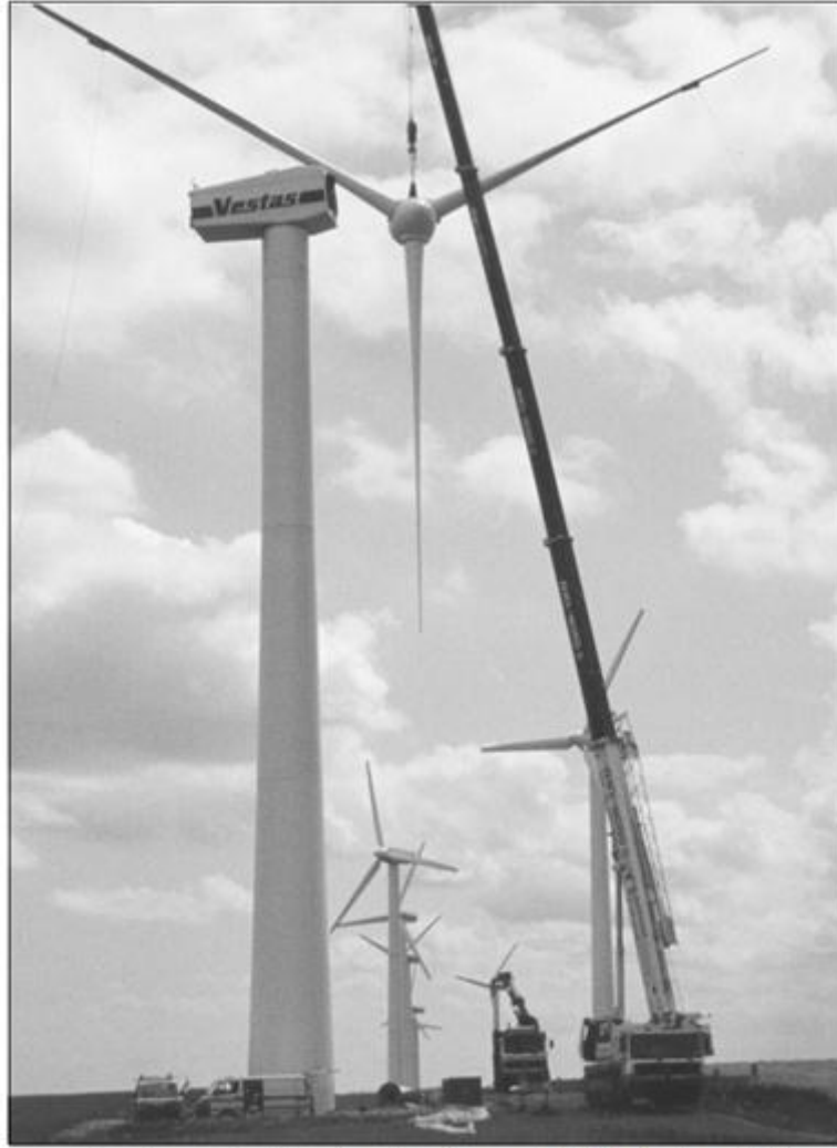
الشكل رقم ( ٩ ) : تجميع الريش على الارض ورفعها
