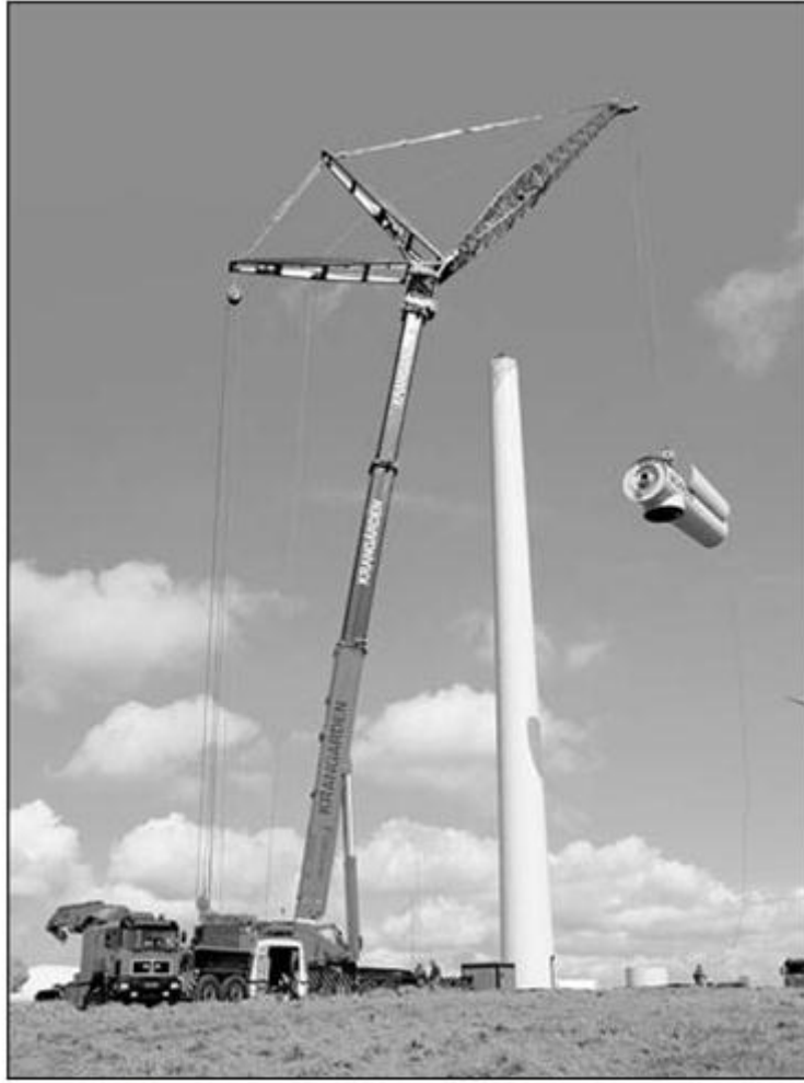
الشكل رقم (١٢) : رفع الناسيل الى قمة البرج
