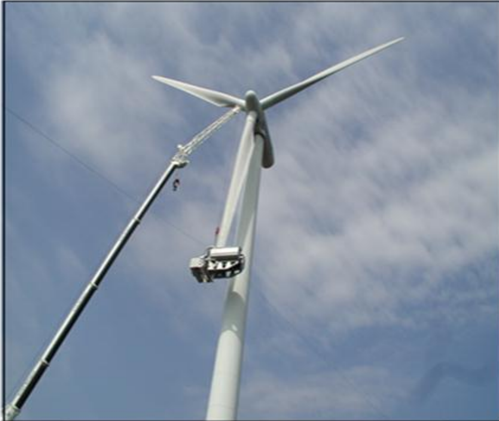
الشكل رقم (٨) : تنفيذ عملية غسل الريش
