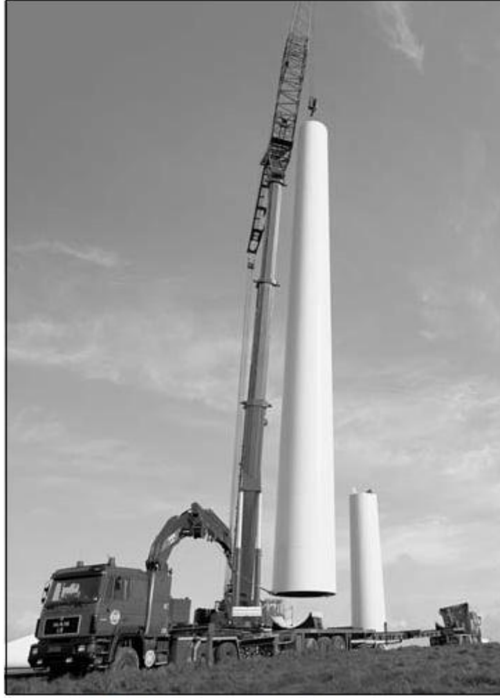
الشكل رقم (١٠) : رفع البرج لتركيبه على القاعدة
