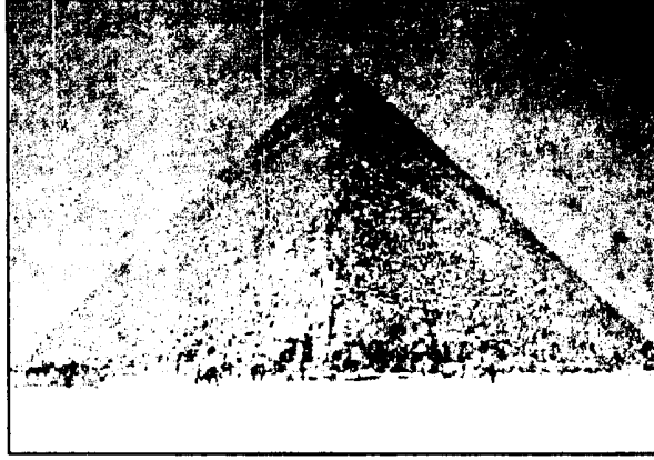
الهرم الأكبر يقال إنه تم بناؤه بسبب توقع حدوث الطوفان
