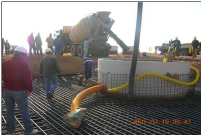
الشكل رقم (٢٥) : عملية تجهيز القاعدة الخرسانية
