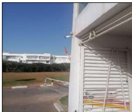
Photo9: caméra vidéo à l'entrée du parking, l'auteur
