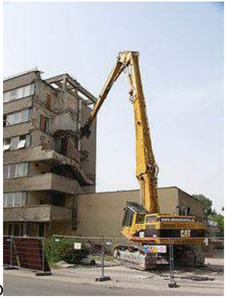
D350D آلة الهدم كات 365 B قيد التشغيل
