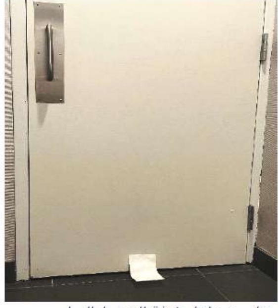
منظر من داخل غرفة الضغط السلبي.
