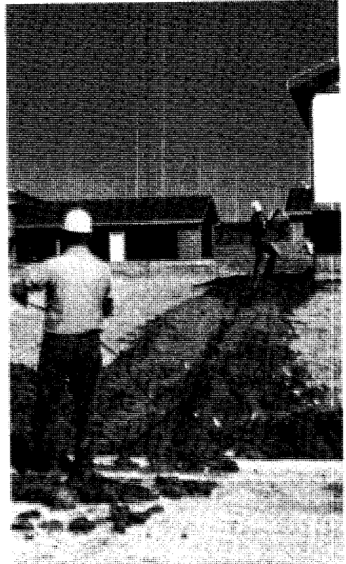
خطوط خدمة الغاز توزع الغاز على بيوت ملايين المستهلكين. وتظهر هنا عملية مد الخطوط إلى حي حديث.
