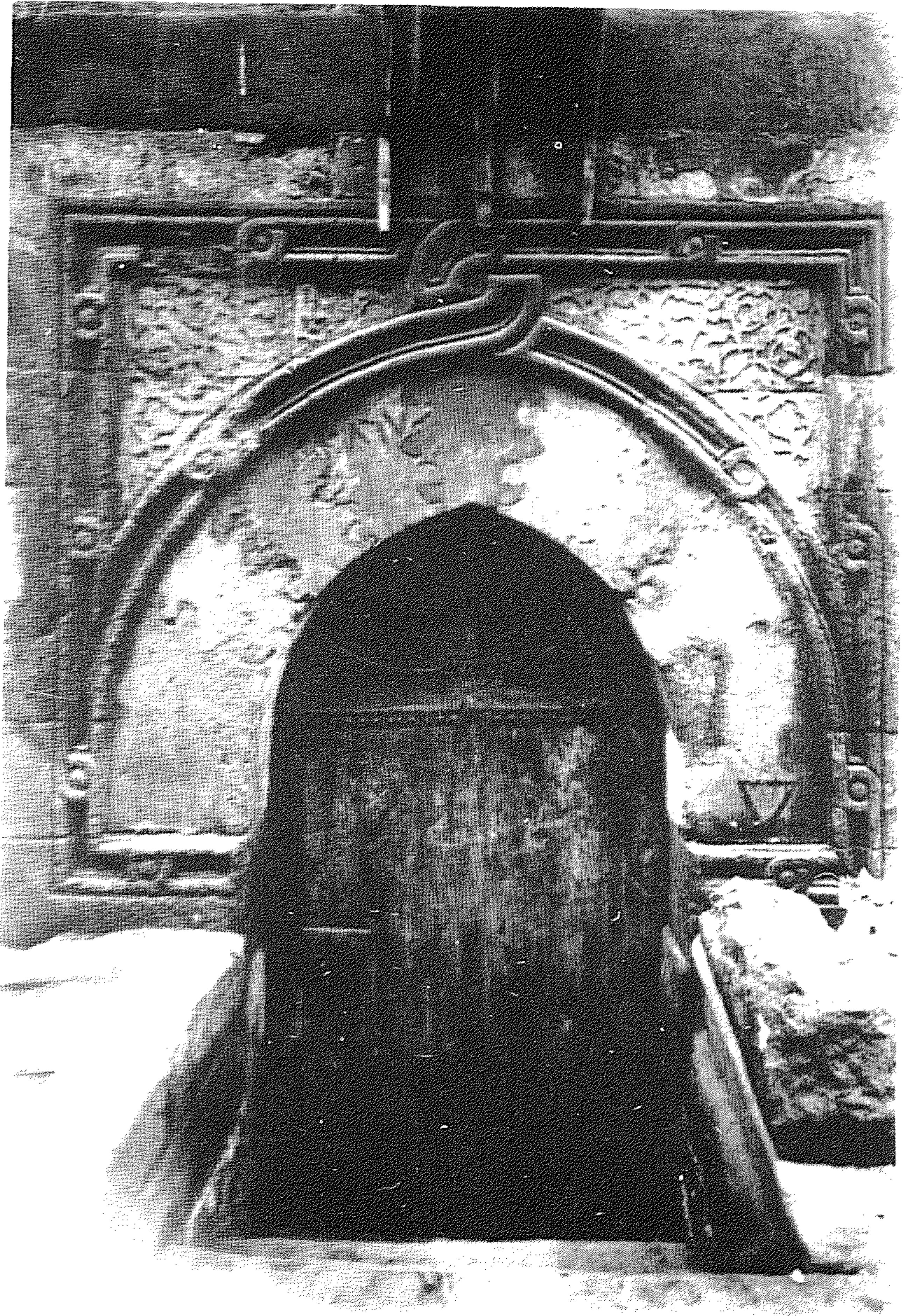
شكل ٨ : مدخل الممر المنكسر الرئيسي بجدار الدركاه الشمالي
