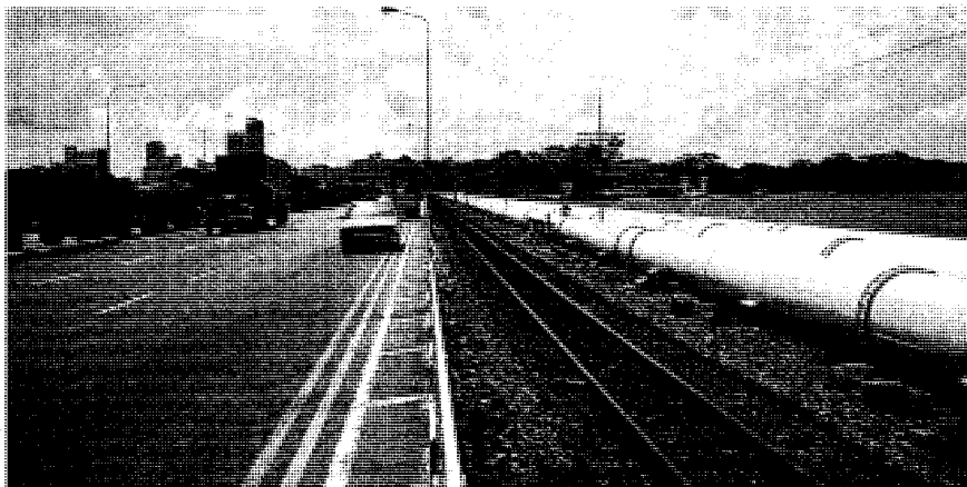
خطوط أنابيب المياه التي تنقل المياه من ماليزيا إلى سنغافورة.
