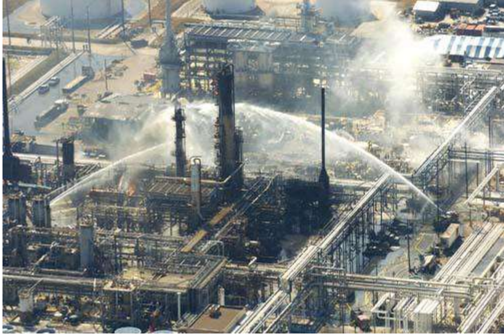
عمليات إطفاء الحريق بعد انفجار مصفاة تكساس سيتي
