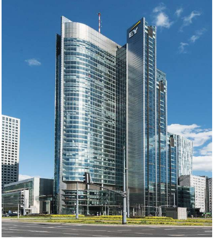
مبنى مكاتب روندو 1 في وارسو
