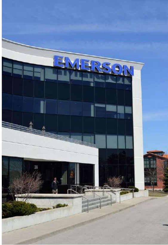
مكتب إيمرسون الكهربائي
