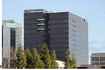
مبنى إكسبيديا، في وسط مدينة بالفيو، واشنطن. 4445
