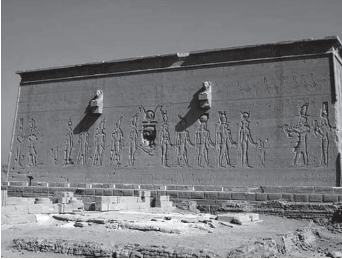
شكل ٤-١٢: الجدار الجنوبي لمعبد حتحور في دندرة.
