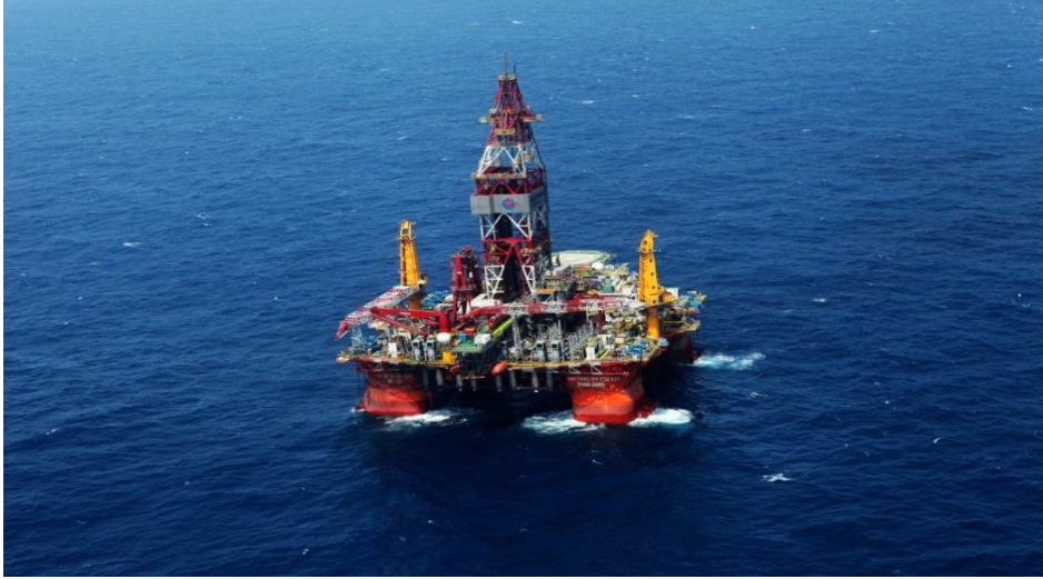
منصة لشركة (صينوك) في المياه العميقة في (بحر الصين الجنوبي)
