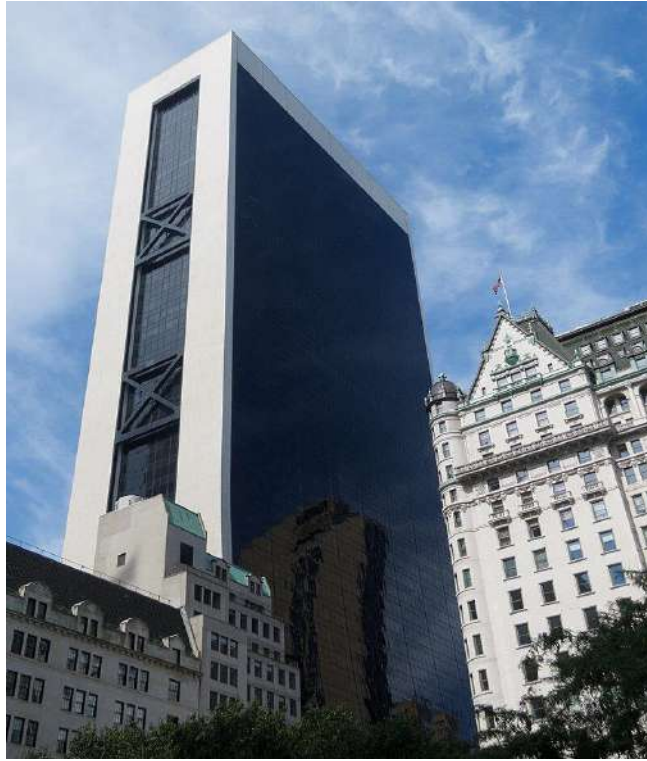
مبنى سولو في وسط مانهاتن، مدينة نيويورك
