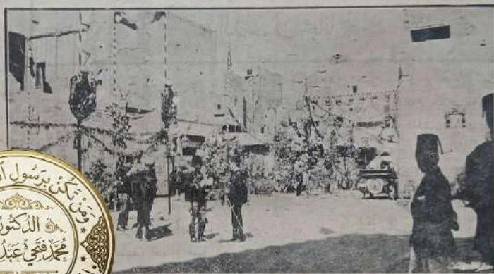
منظر خارج الجامع حيث نصبت الزينات ولقت الاعمدة بقماتها للوقوف بعين الحرس المن
