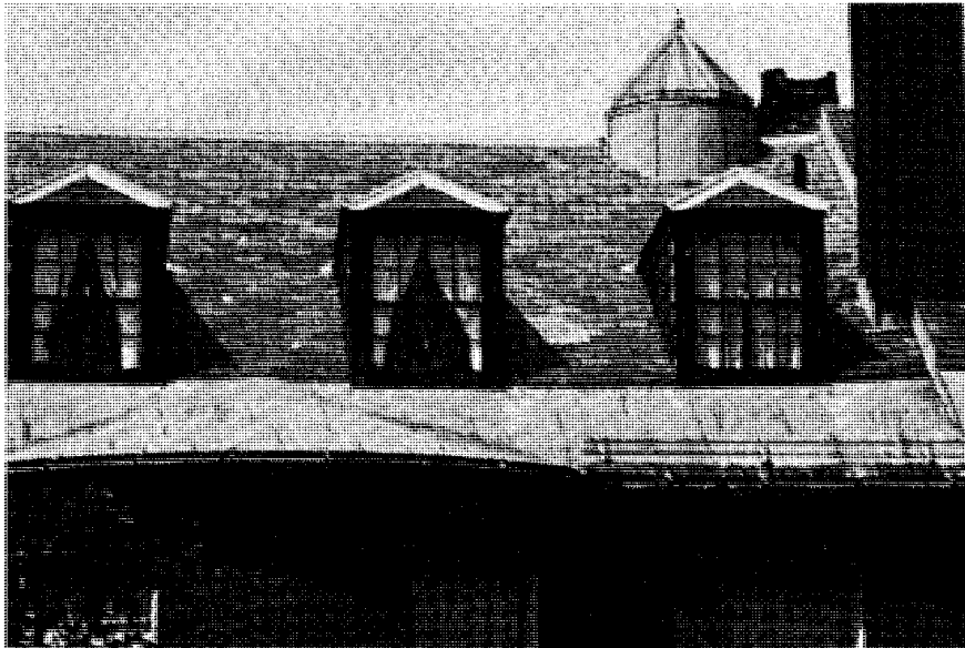
التآكل المنتظم . نوع شائع من التآكل الذي يهاجم مناطق كبيرة. وهو ينتج طبقة رقيقة مخضرة تعرف باسم الزنجار حينما تحدث على سطح مثل السقف النحاسي الذي يبدو في الصورة.
