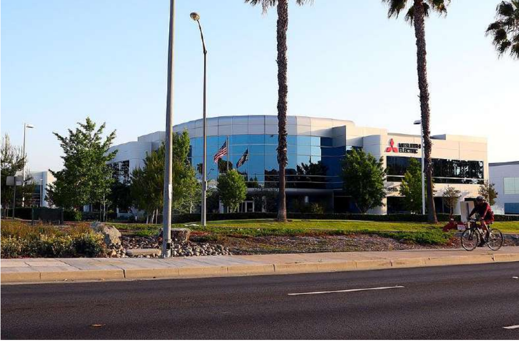
منظر أمامي للمقر الرئيسي لشركة Mitsubishi Electric في الولايات المتحدة (المبنى A) في سايبيريس، كاليفورنيا،
