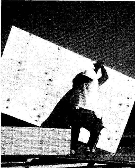
خشب الأبلكاش متعدد الطبقات الخشبية، يقوم أحد العمال بإعداده لاستخدامه في عمليات البناء.
