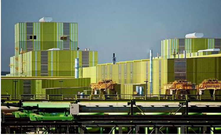
منظر لخطوط الجلفنة بالغمس الساخن في ThyssenKrupp Steel USA في كاليفيرت، ألاباما
