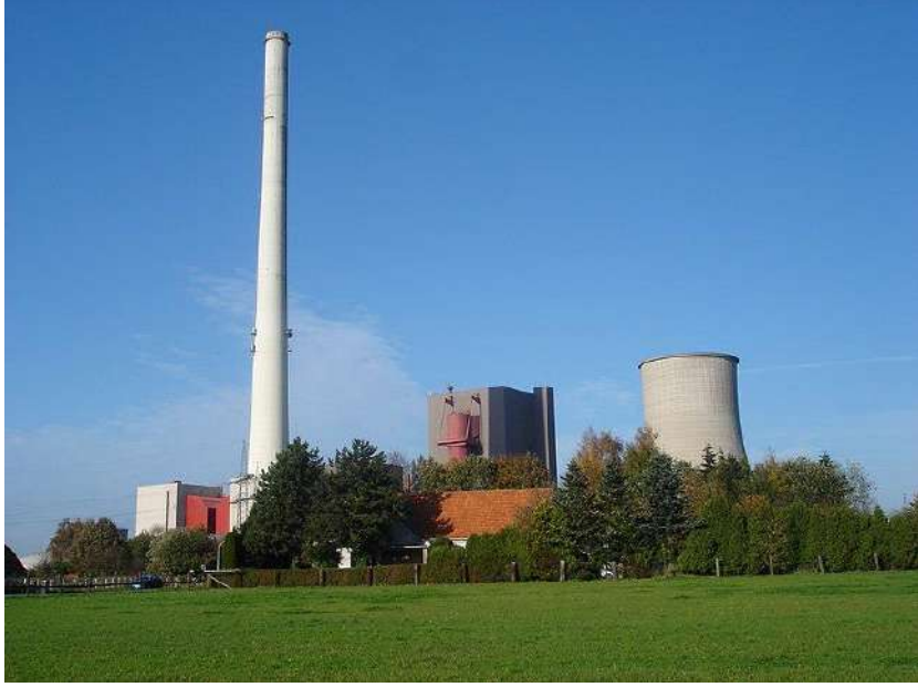
محطة توليد الطاقة RWE في مدينة إبنورن
