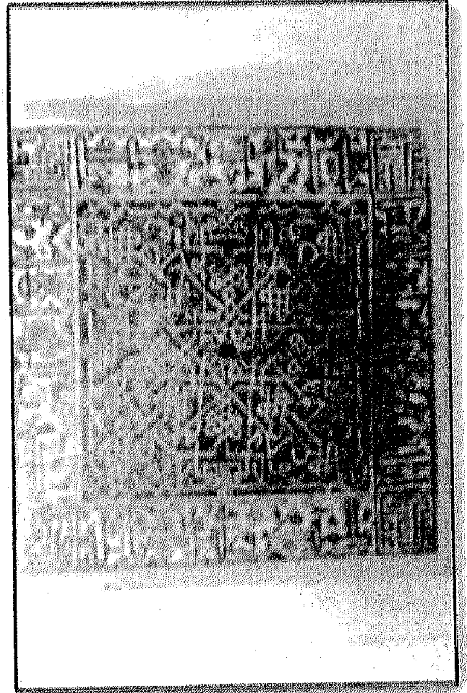
لوحة (٢٧٧) عتب مستقيم ونقيس وعمد عائق ذو صنجات مزرر تزويرا مركباً مدخل مسجد تنم رصاص المعروف بمسجد تميم الرصافي بالسيدة زينب
