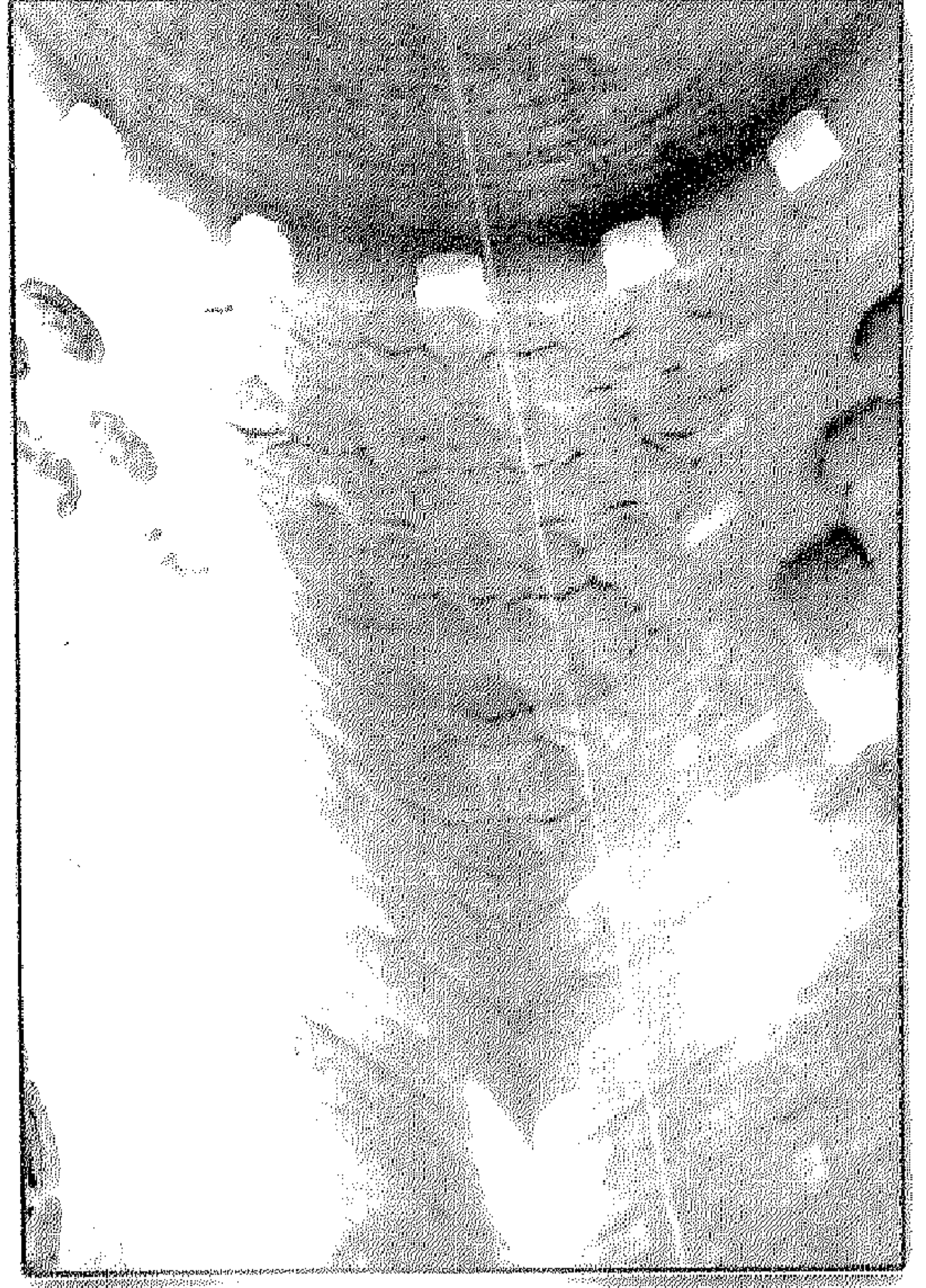
لوحة ( ٢٢١ ) مناطق انتقال القباب : سراويل مقرنص ( ٩ حطات تعتمد على ذيل هايط ) .
