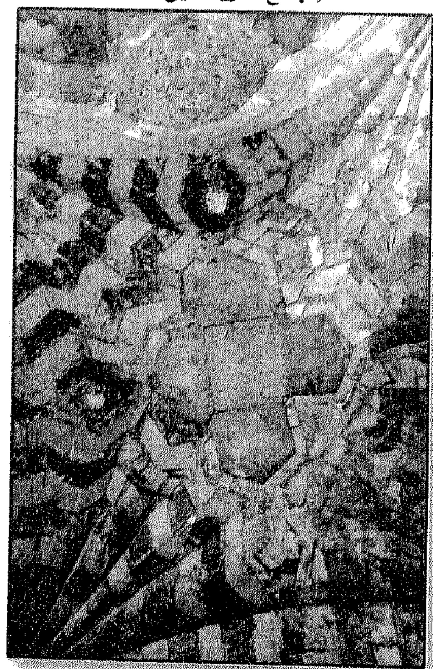
لوحة ( ٢٧٤ ) قبو مروحي يتوسطه شكل متقاطع ( جامع المؤيد شيخ ) .
