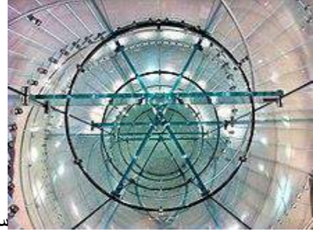
سلم حلزوني داخل متجر أبل ستور في بوسطن
