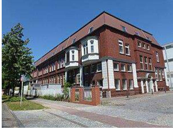
المدخل الرئيسي السابق لمبنى إدارة الكيـت في Breitenbachstraße في برلين
