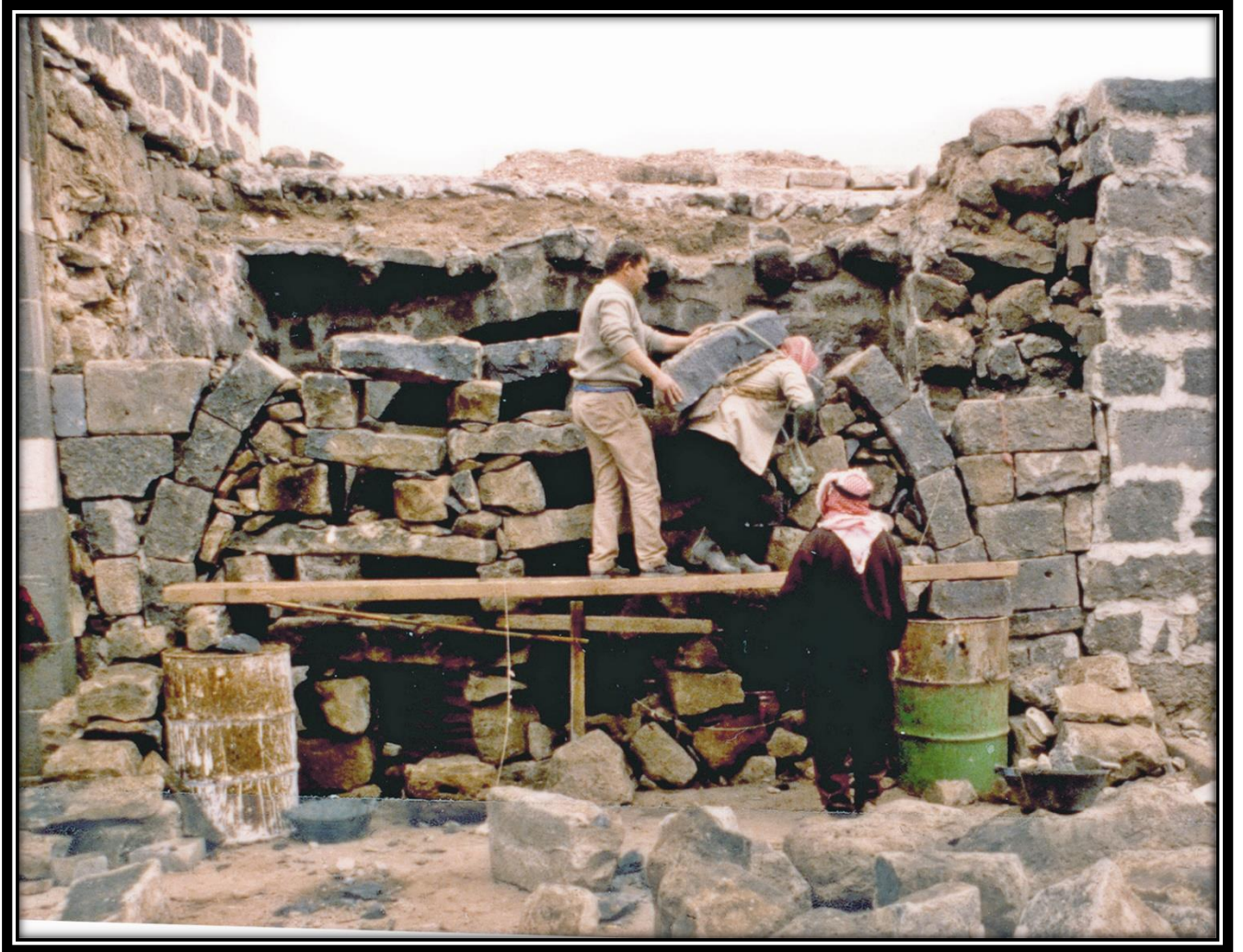
بصرى الشام ١٩٩٦ م, ترميم مطعم البلدة القديم
