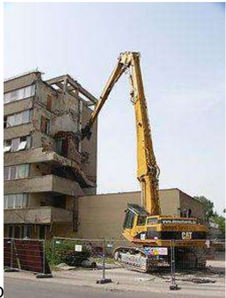
D350D آلة الهدم كات 365 B قيد التشغيل
