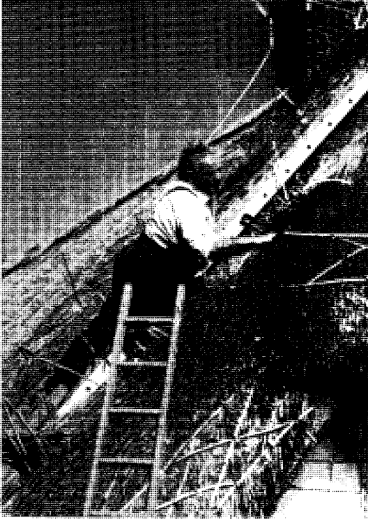
السقّاف لاتزال هناك حاجة للسقّافين في أجزاء عديدة من جنوب إنجلترا، وويلز، وأيرلندا. وهم يقومون بوضع أغطية جديدة على أسقف المنازل القديمة أو يصلحونها.
