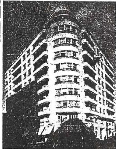
عمارة شركة الشمس بالمبتديان دنيل المباني
