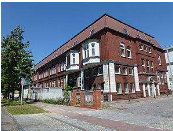
المدخل الرئيسي السابق لمبنى إدارة الكيت في Breitenbachstraße في برلين
