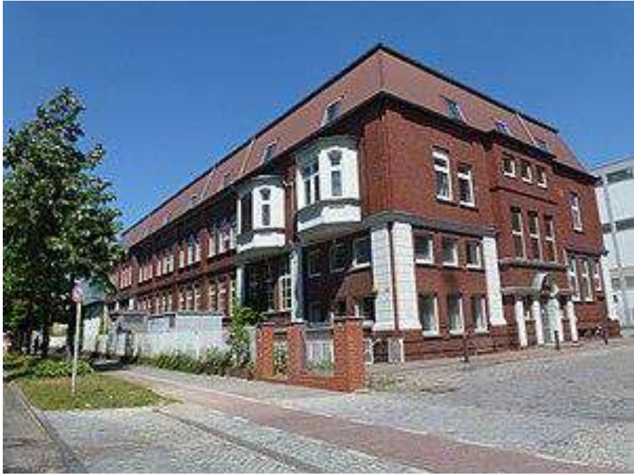
المدخل الرئيسي السابق لمبنى إدارة الكيت في Breitenbachstraße في برلين
